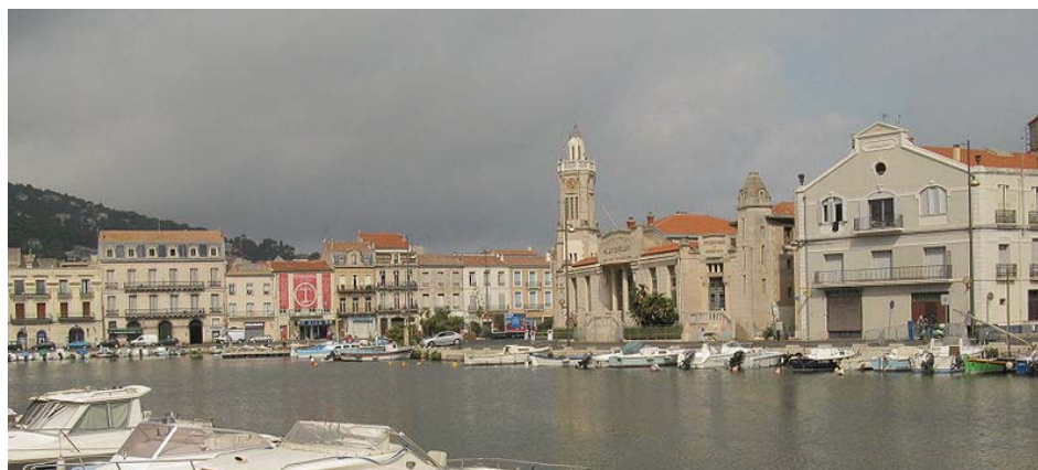
Le Canal Royal à Sète, Hérault, France.
